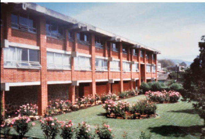
3.- Vista trasera de las últimas construcciones de los edificios 3 y 4 4.- Fachada del edificio 1 de la Universidad Don Vasco
