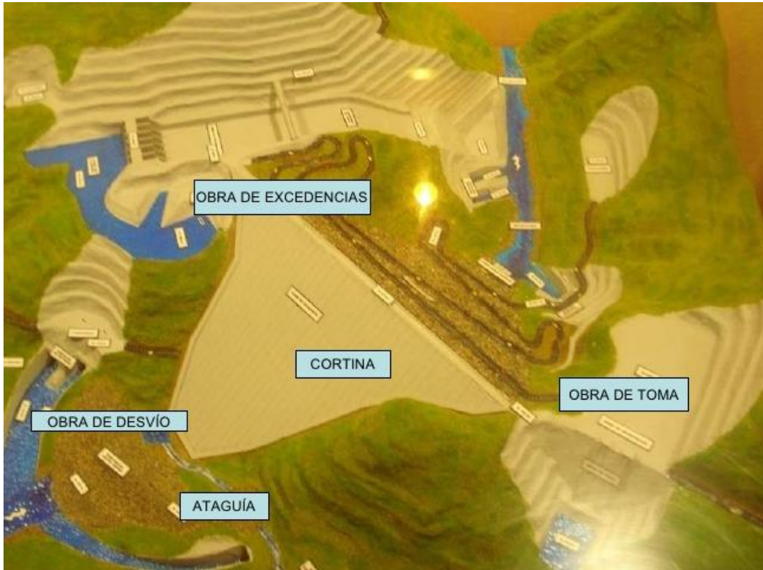
Figura 3. Obras Principales de una Central Hidroeléctrica. (1.c)
