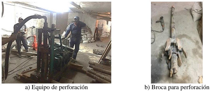
Figura 2.6 Perforación previa al hincado de pilotes (cortesía de PICOSA, 2017).
