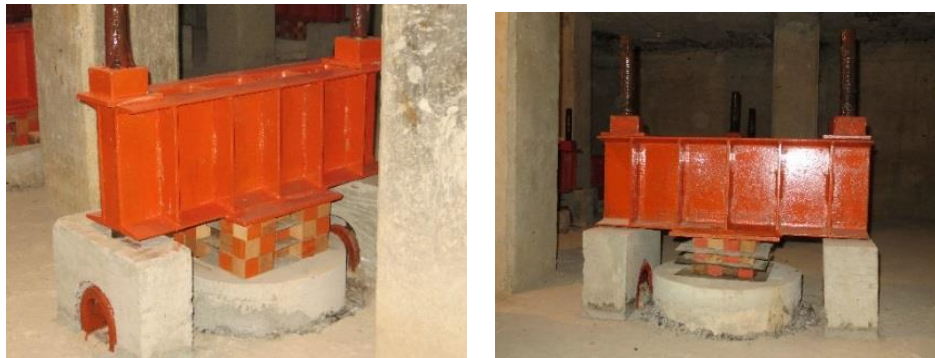
Figura 2.35 Pilotes de punta existentes en un hotel de la Ciudad de México, recortados y habilitados con sistema de control en la cabeza.
