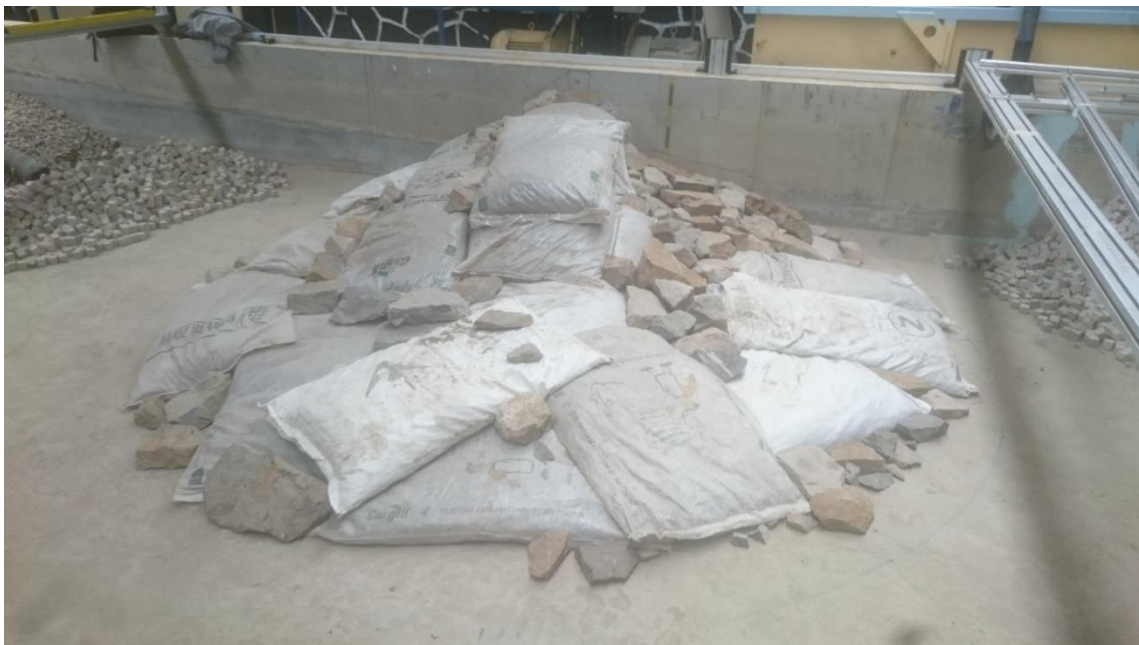
Figura 3.25 Construcción final del núcleo girado del morro
