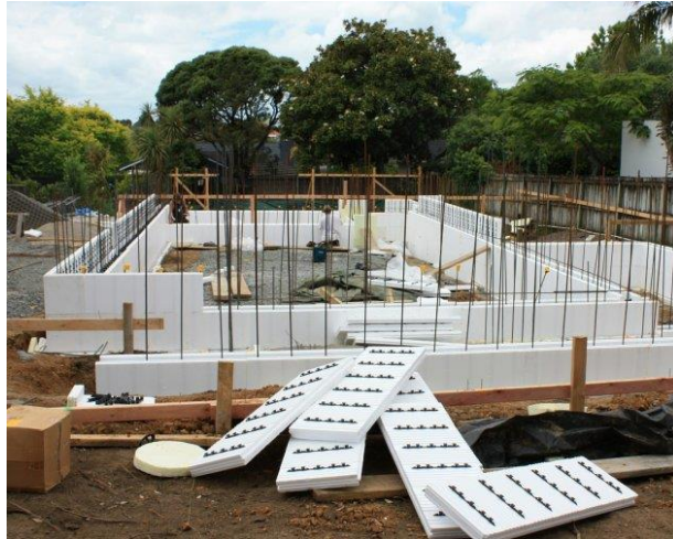
Figura 25 Construcción con paneles de plástico. Fuente ICF ECO-Block.
