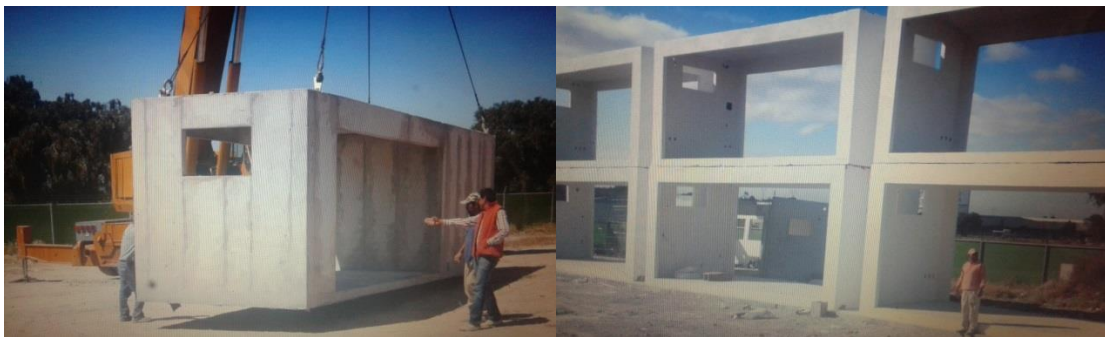
FIGURA 26 transporte y colocación de estructuras prefabricadas para la construcción. Fuente COSOL
