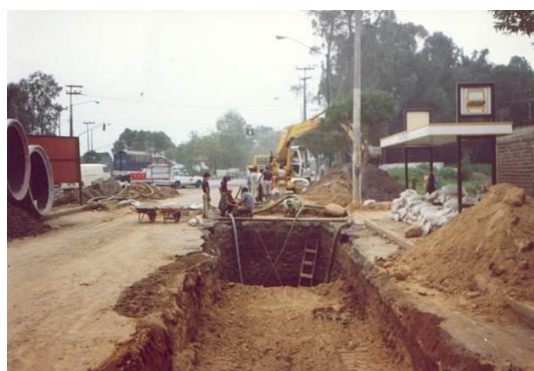
Figura 27 microtuneleo contra excavación a cielo abierto. Fuente: AMITOS (2004)
