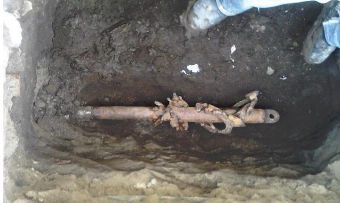
Figura 12 Cabezal de tiro de perforación dirigida. Fuente: hperfora & Company (1998)
