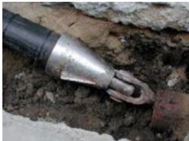
Figura 6 Línea de tiro, cuchilla, expansor y tubería de sustitución. Fuente: Olsen Plant & Services (2010)
