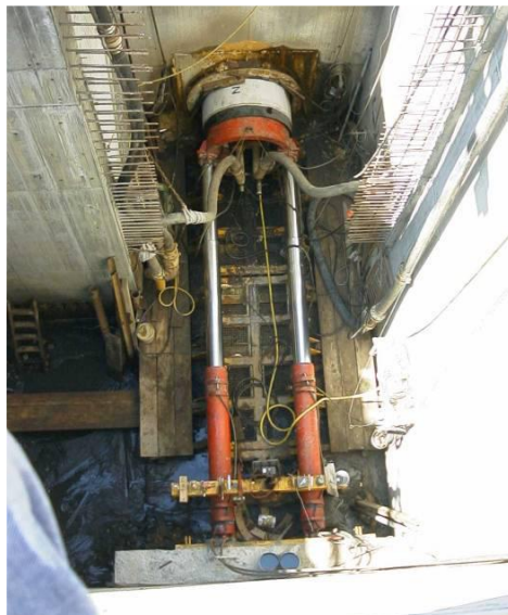
Figura 36 Pozo de ataque y sistema de empuje. Fuente: Pedraplus, I. (2014)
