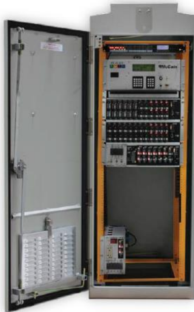
Figura 3.61. Controlador de semáforos con sincronía GPS Fuente: (Evans, 2016)
