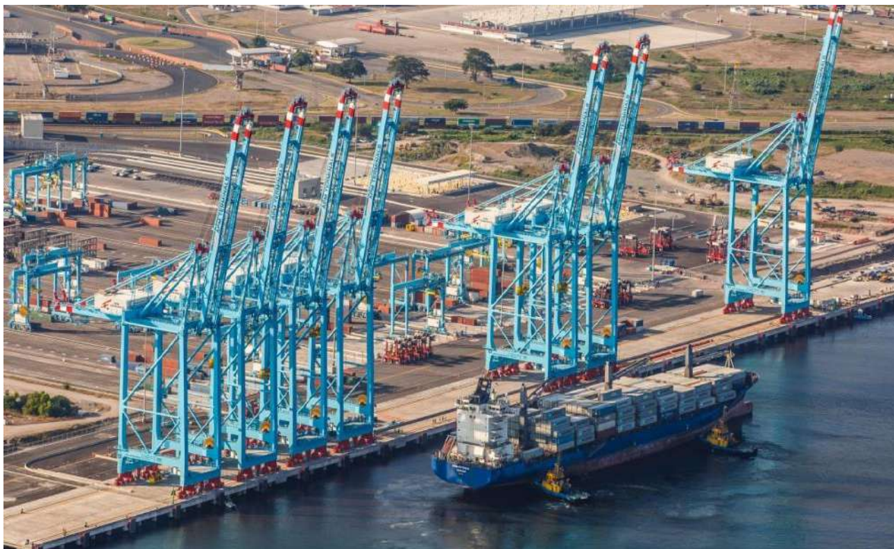
Figura 3.8 Terminal Especializada de Contenedores II, patio y grúas pórtico Ship-to-shore.
