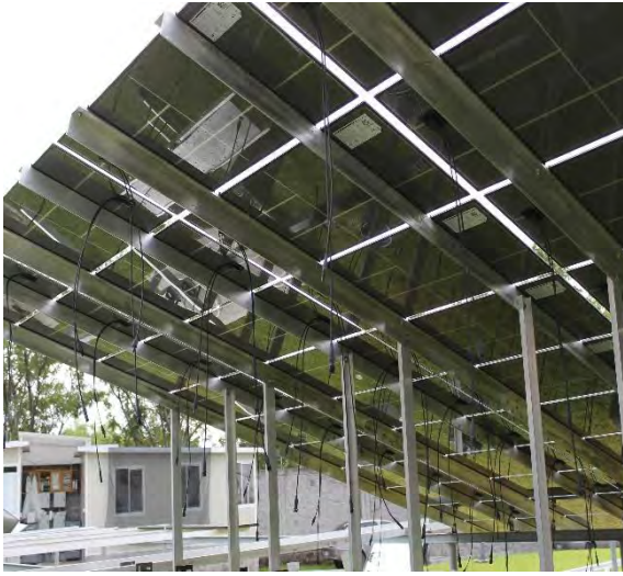
Figura 18 Instalación mecánica de la Plataforma SFV
