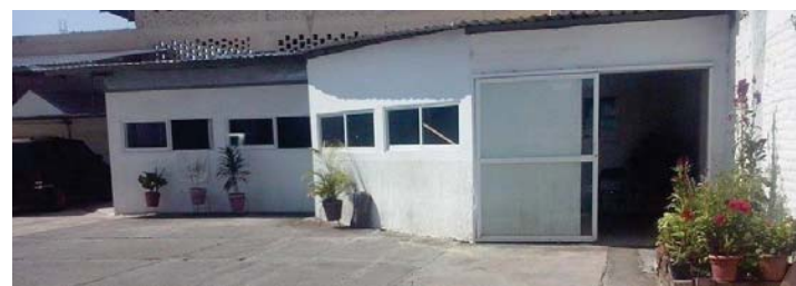
Fachada exterior del Área Básica de Rehabilitación.
