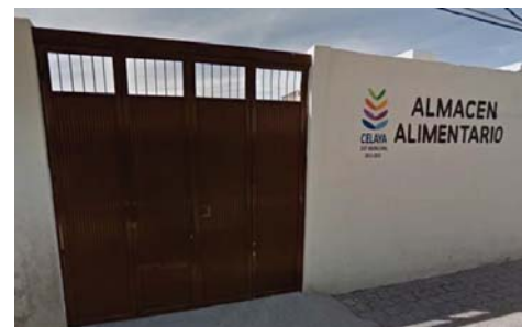
Fachada de acceso al área carga y descarga
