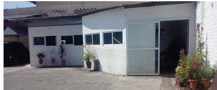
Fachada exterior del Área Básica de Rehabilitación.
