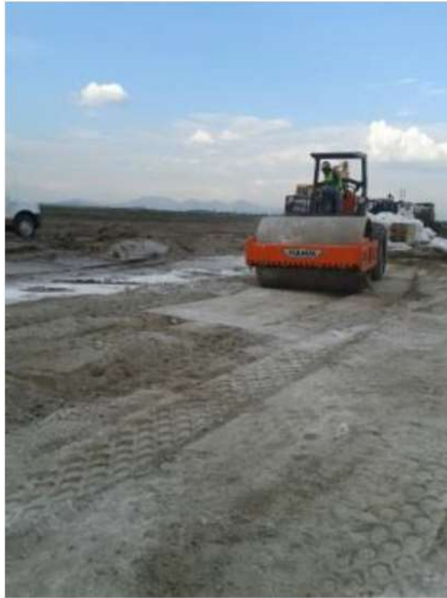
Imagen 8. Cerrado de la capa de mejoramiento con rodillo estático.
