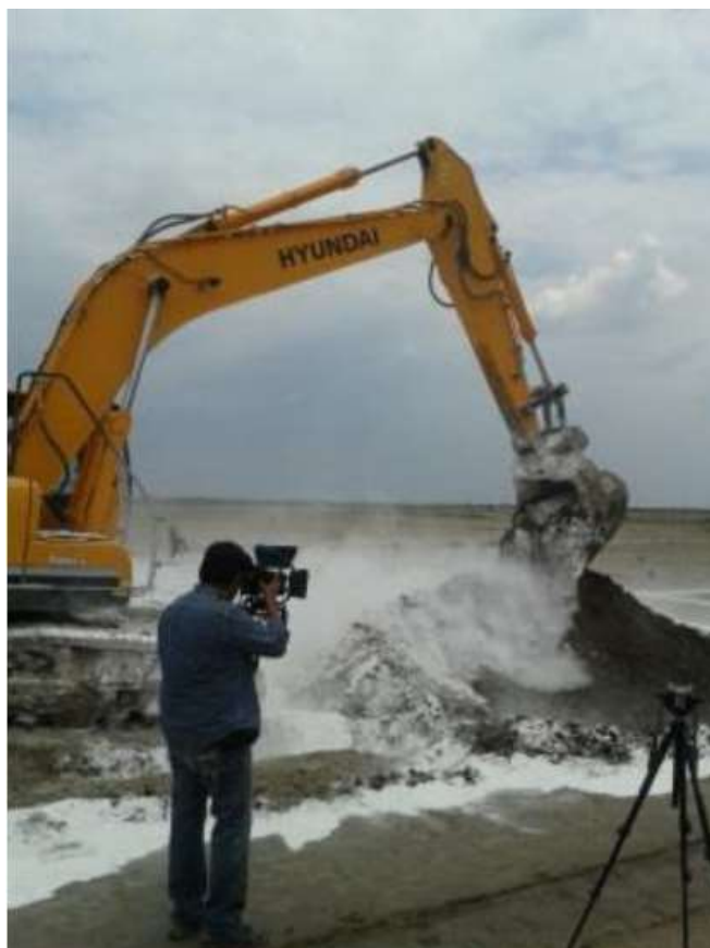
Imagen 7. Mezclado de suelo con CaO.
