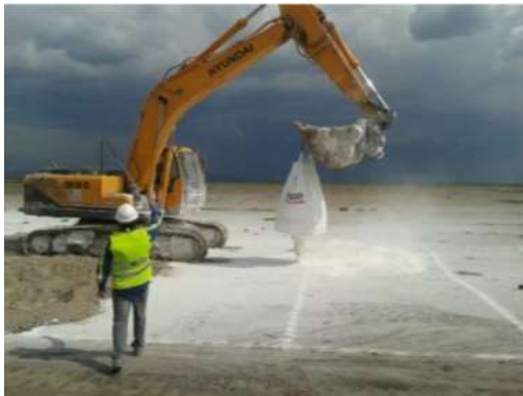
Imagen 6. Dosificación de CaO con saco.
