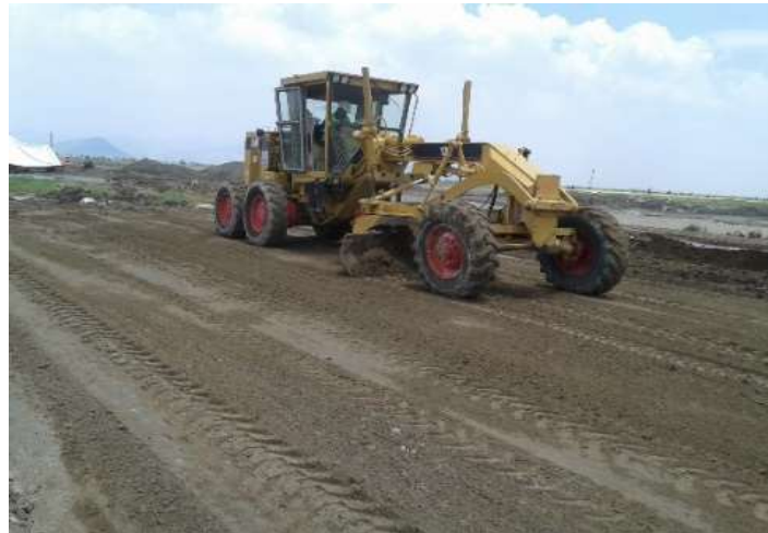
Imagen 9. Nivelación de plataforma con motoconformadora.
