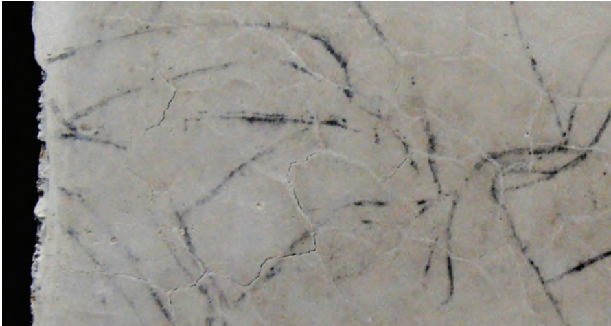
Fig. 17 Detalle de la grieta más grande del soporte
