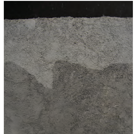
Fig. 10 Se humedeció el panel para la aplicación del enlucido
