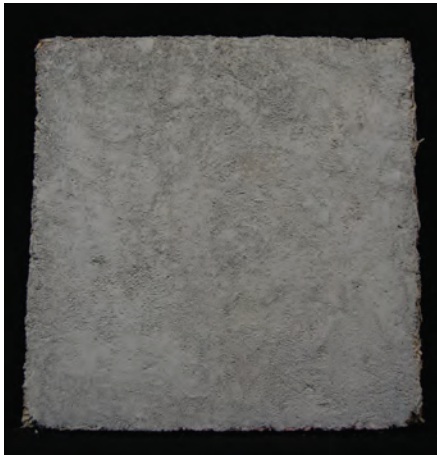
Fig. 9 Repellado seco. Se nota el cambio en la tonalidad una vez seco
