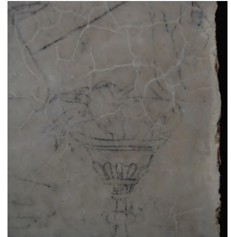
Fig. 18 Se dio una lechada al enlucido, tratando de rellenar las grietas más grandes y evitar que se hicieran más profundas
