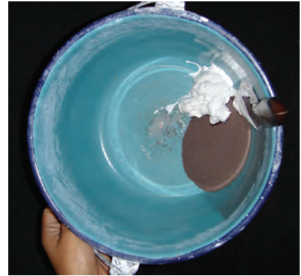
Fig. 3 Se mezclaron el tezontle y el hidróxido de calcio para el repellado.
