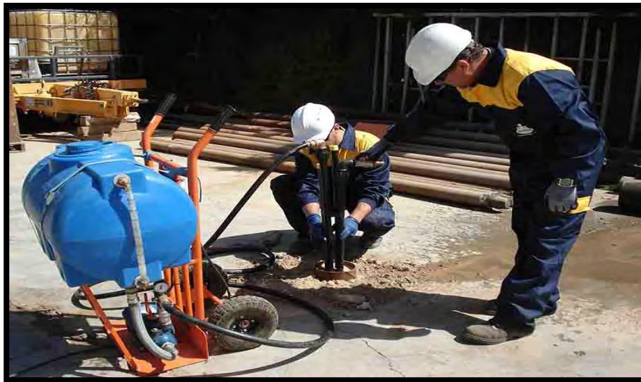
Imagen 6. Llenado y presionado de una tubería con obturadores.
