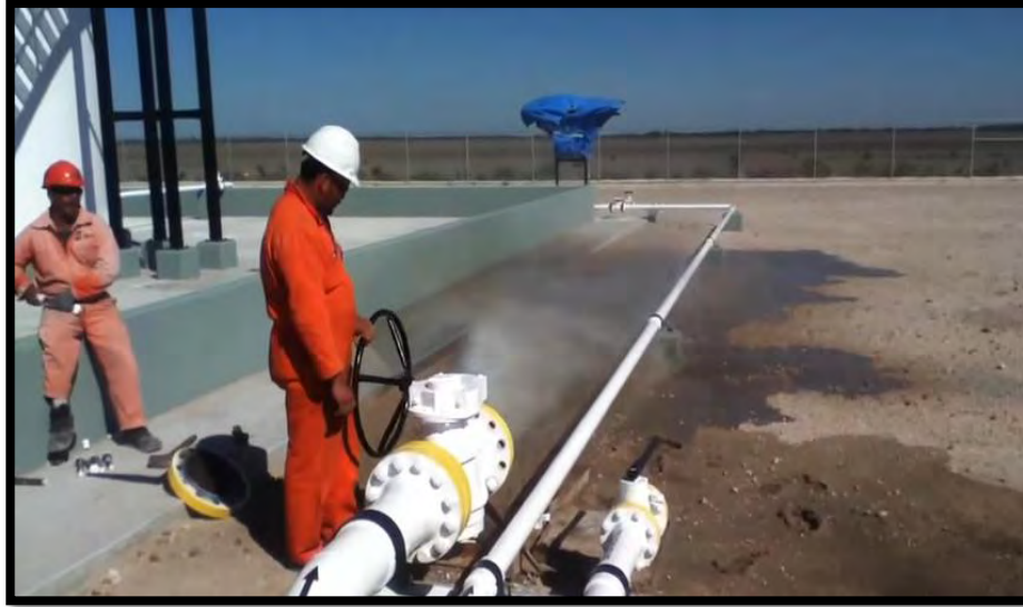
Imagen 22. Salida de aire a presión de la tubería.
