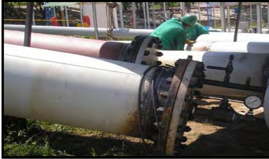
Imagen 7. Verificación de fugas en las uniones y bridas de las tuberías.
