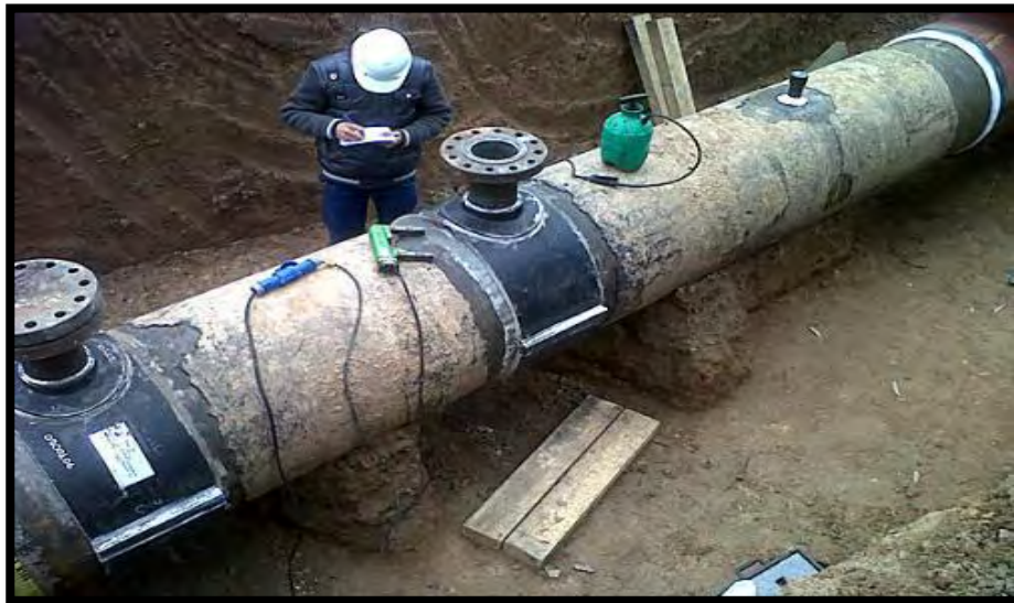
Imagen 5. Inspección y aceptación de soldadura.
