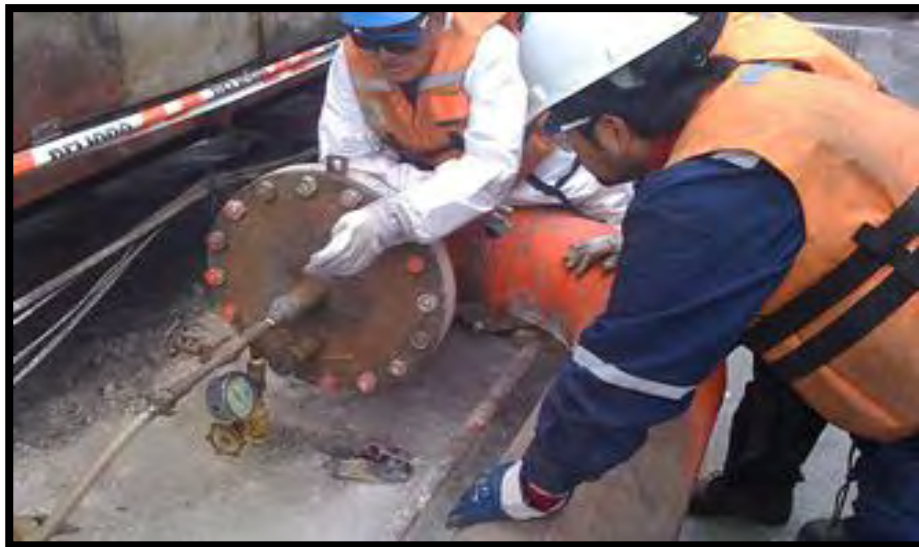
Imagen 20. Colocación de brida con entrada o salida de fluido.
