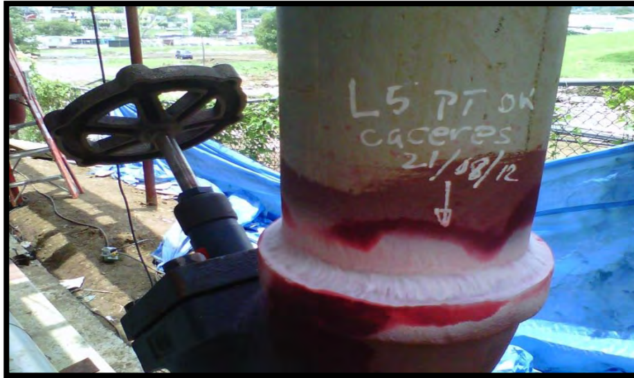
Imagen 3. Prueba de líquido penetrante a tubería.
