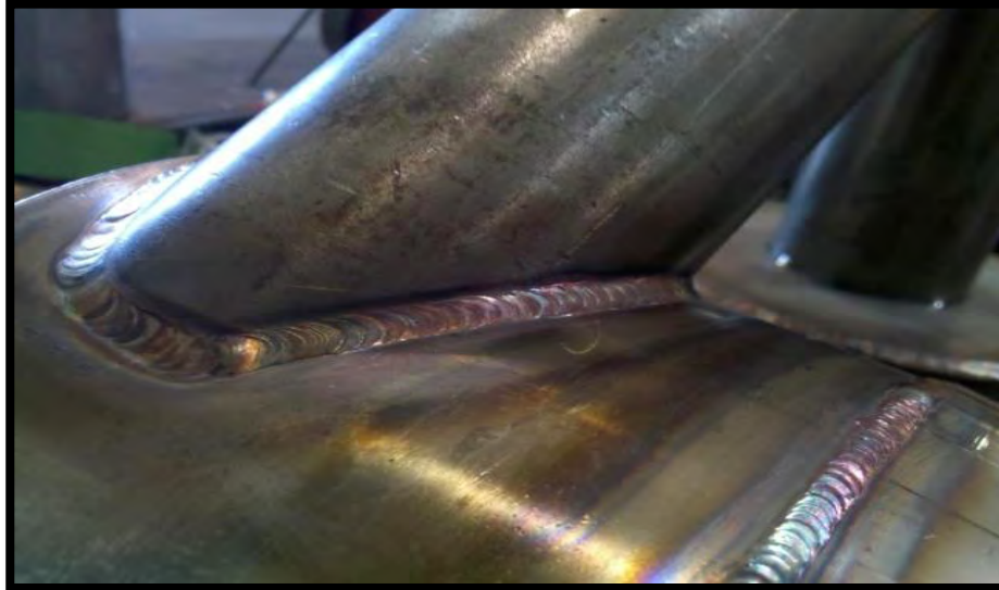
Imagen 11. Soldadura en tubería de acero inoxidable.
