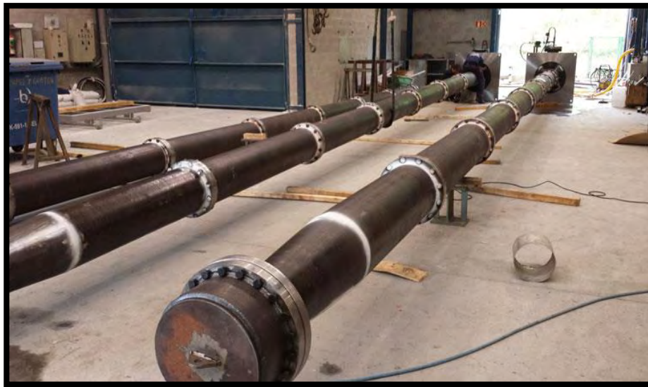
Imagen 8. Prueba de resistencia mecánica en uniones y bridas de la tubería.
