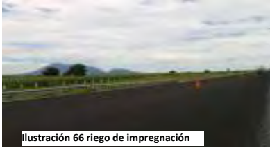
Ilustración 66 riego de impregnación
