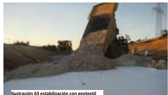
Ilustración 63 estabilización con geotextil
