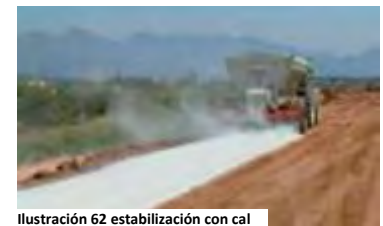
Ilustración 62 estabilización con cal
