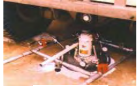
Ilustración 45 Ensayo prueba de placa
