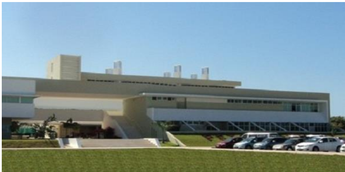
Figura 3. Edificio actual de la Facultad de Psicología
