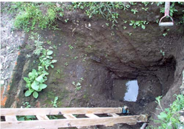
Figura 2.1. Excavación en el pozo PCA2
