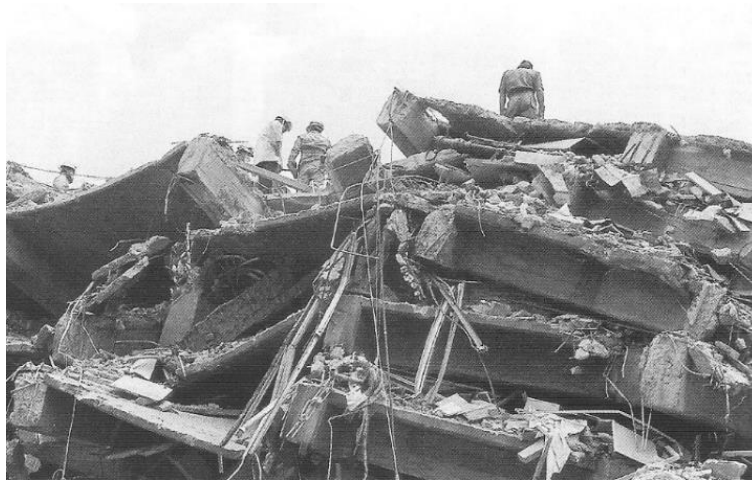
Figura 2.19 Colapso de la Torre de Hospitalización, Ricardo Pérez Santillán
