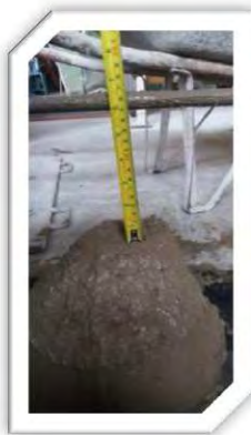
Fig. 5.20.- Verificación del revenimiento de la mezcla.
