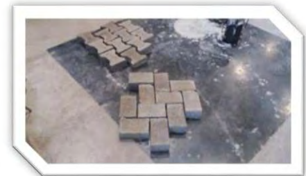
Fig. 5.13.- Día posterior a la fabricación de los adoquines, se verifica la forma de colocación de estos.
