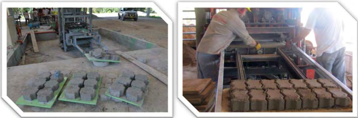
Fig. 1.3.- Fabricación mecanizada de grandes lotes de adoquines. [31]
