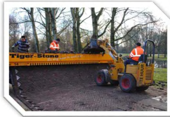
Fig. 1.5.- Colocación de adoquines con pavimentadora. [33]
