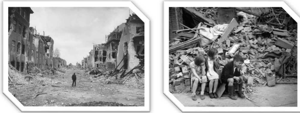
Fig. 1.6.- Los escombros originados a causa de la segunda guerra mundial, tuvieron que ser reutilizados por las naciones Europeas afectadas, para llevar a cabo la reconstrucción de sus ciudades. [34]
