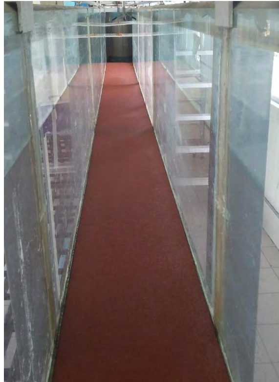
b) Vista hacia aguas arriba
