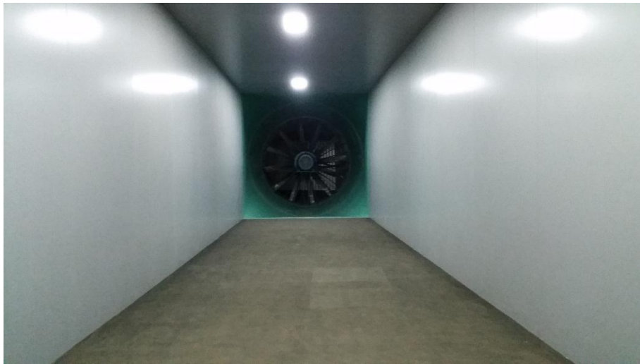
Figura 6: Imagen del difusor del ventilador del túnel de viento
