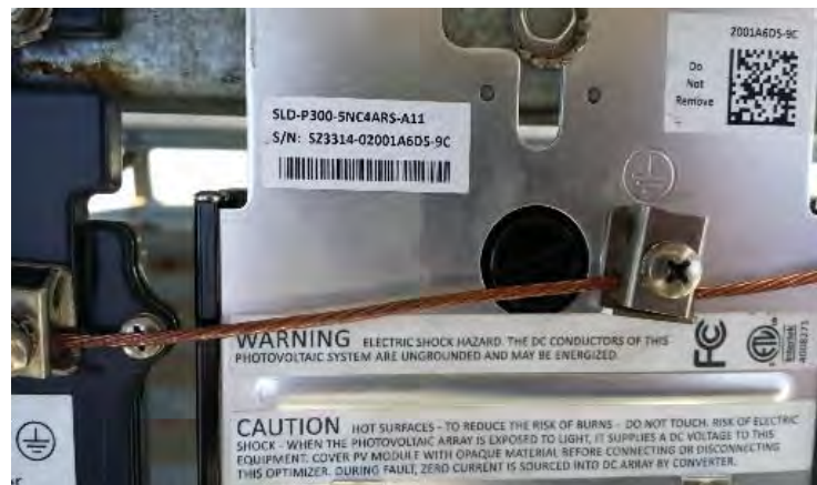
Figura 2.12 Cable tipo desnudo [Fuente: CONUEE]
