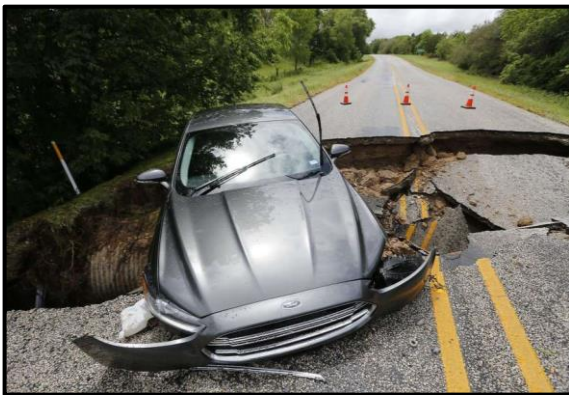
Figura 1.5. Falla de alcantarilla. Texas, U.S. (Statesman 2016)
