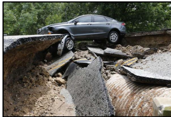
Figura 1.5. Falla de alcantarilla. Texas, U.S. (Statesman 2016)
