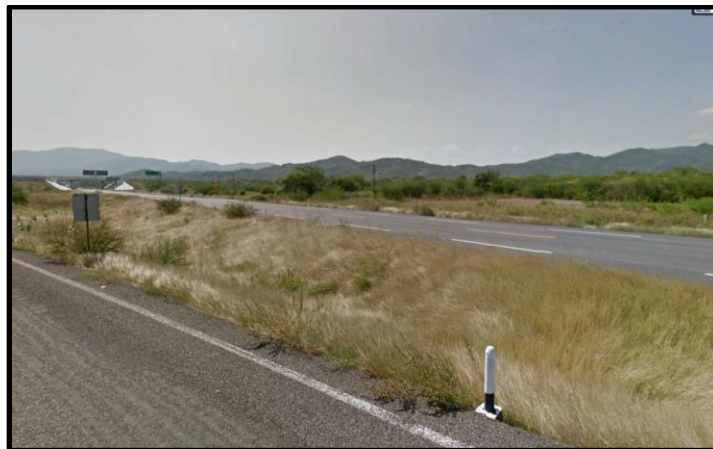
Figura 4.18. Carretera Salina Cruz – La Ventosa. Zona de punto de drenaje 1.
