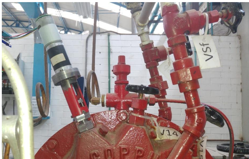
Ilustración 76 instalación de válvula
