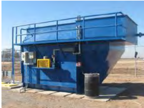
Planta de Tratamiento de Aguas Residuales tipo Paquete Modelo GWT PTAR15000 3 DE 15000 GALONES 56M3
