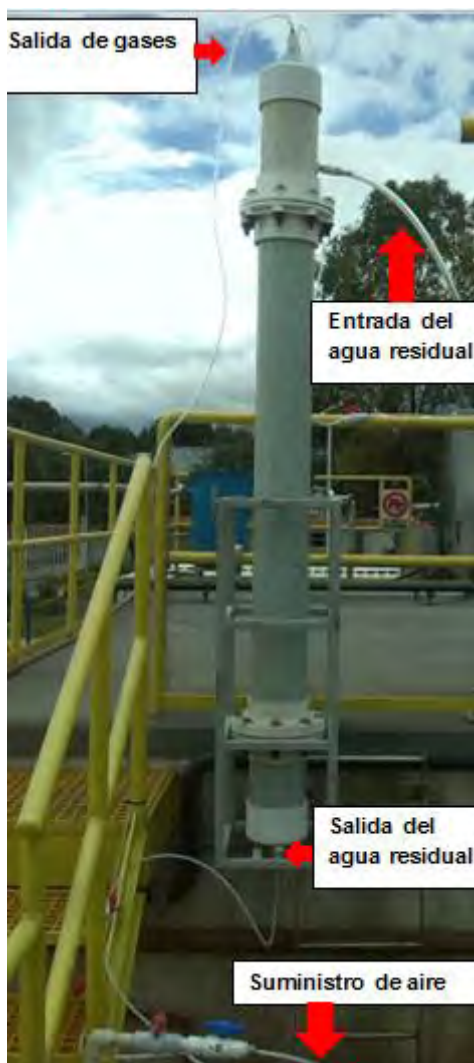
Figura 4.4. Columna para la desorción del biogás
