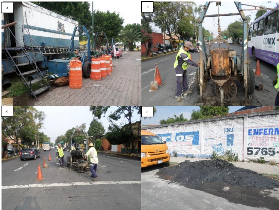
Figura 4.3. Desazolve con equipos de malacates
