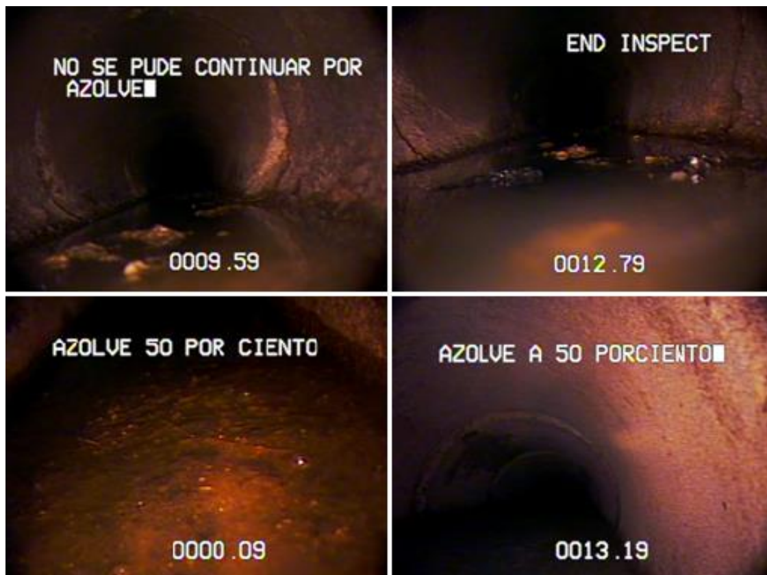
Figura 2.3. Video inspección en atarjeas
