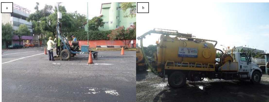
Figura 1.3. Extracción de sedimentos: a) Técnica de malacates, b) Camión hidroneumático
