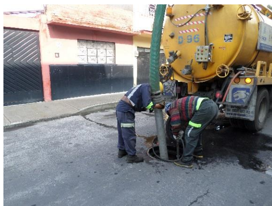
Figura 4.2. Extracción de sedimentos mediante camiones hidroneumáticos
