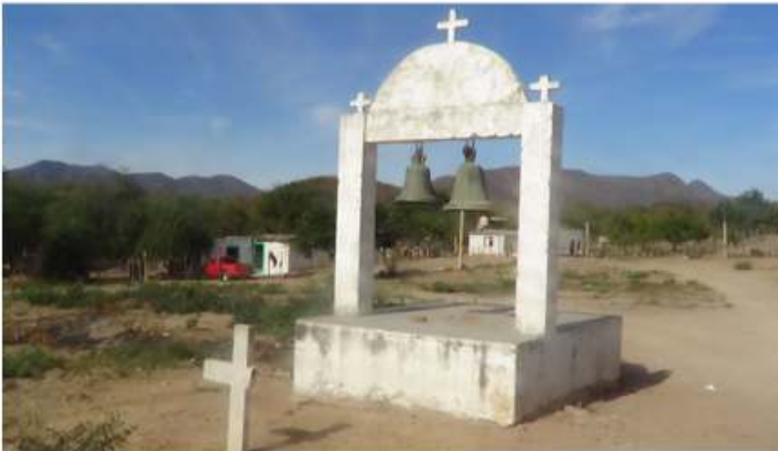
Foto 6. Campanario tradicional yoreme de Mocúzarit-Conicárit, trabajo de campo, abril, 2014.
