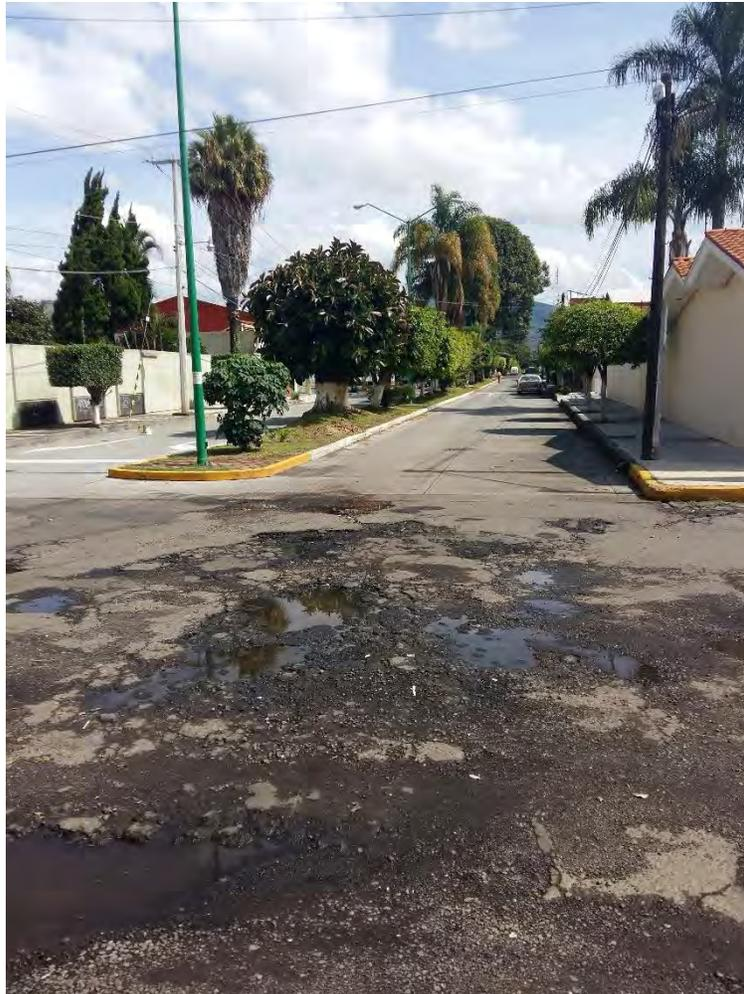
Imagen 3.6 Desprendimientos de la carpeta asfáltica
