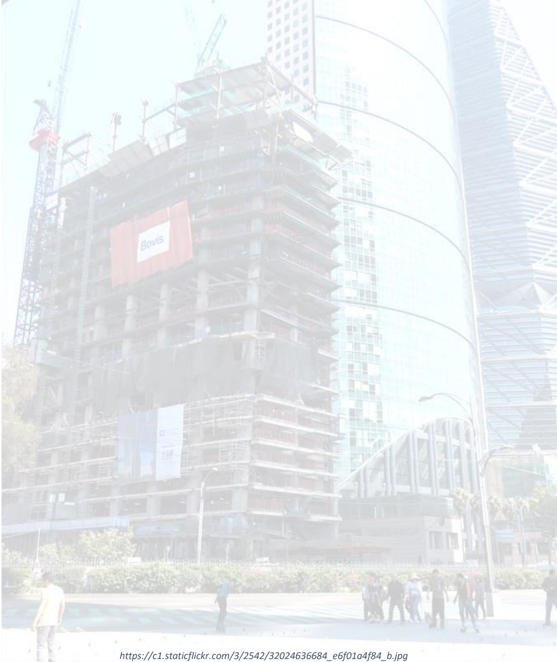
Torre Chapultepec en Construcción
