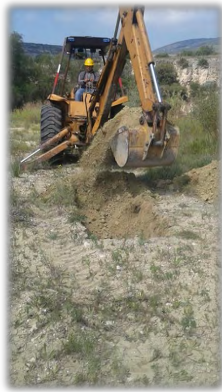
Figura 17 Perforación de PCA
