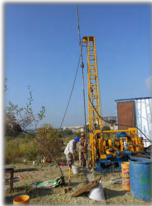
Figura 9 Herramienta de penetración estándar
