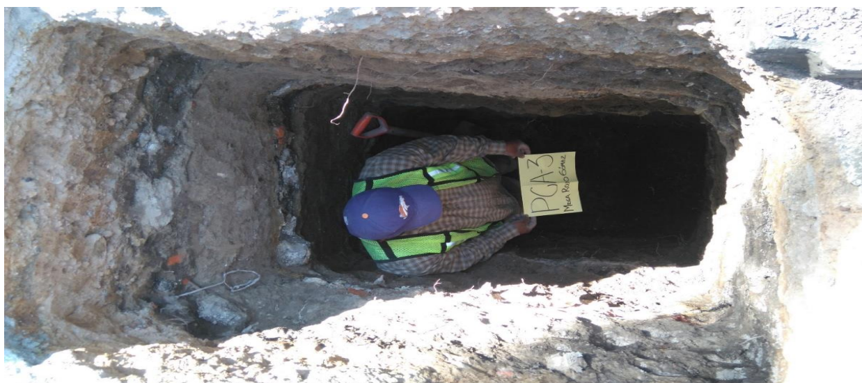
Fig. 8 EXCAVACIÓN DE POZO NOMBRADO PCA-3
