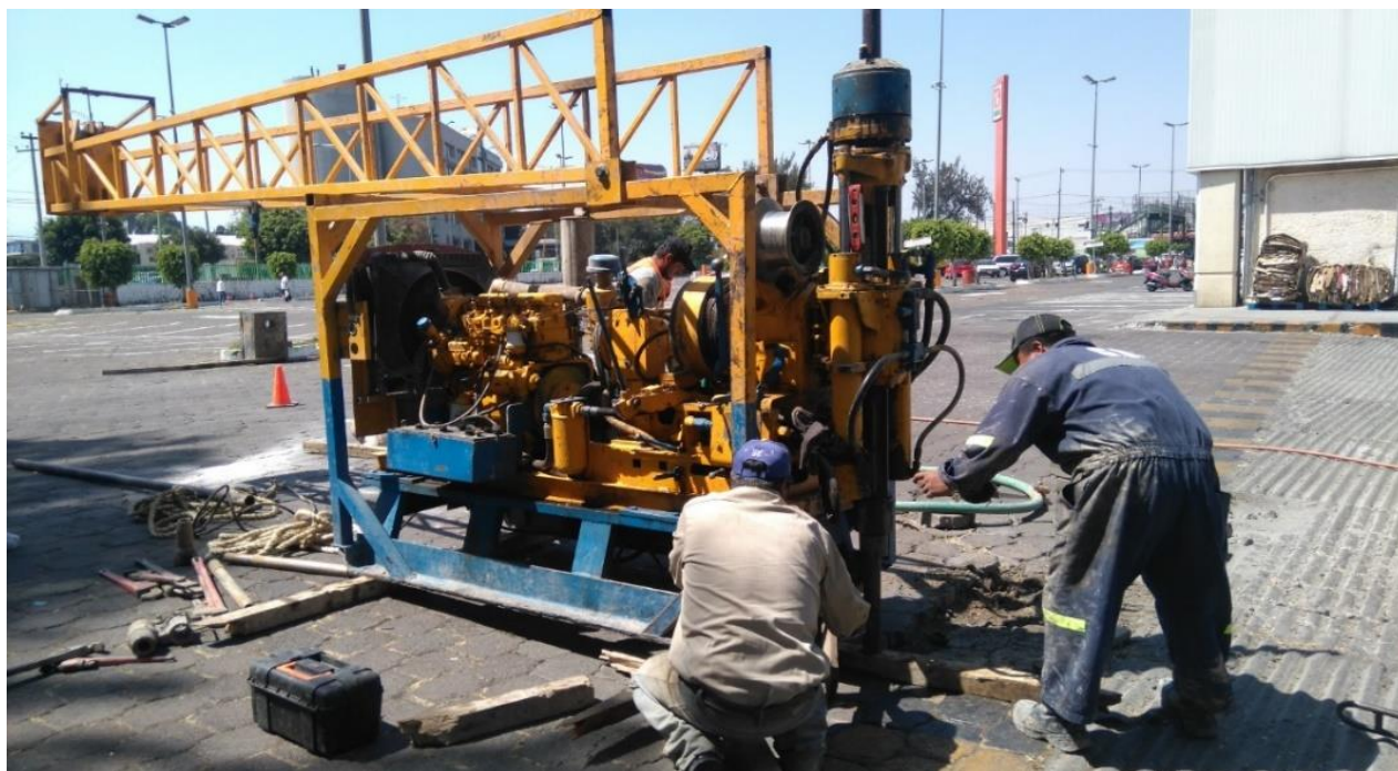
Fig. 7 SONDEO PROFUNDO DE TIPO MIXTO REALIZADO CON MAQUINA LONG YEAR 34
