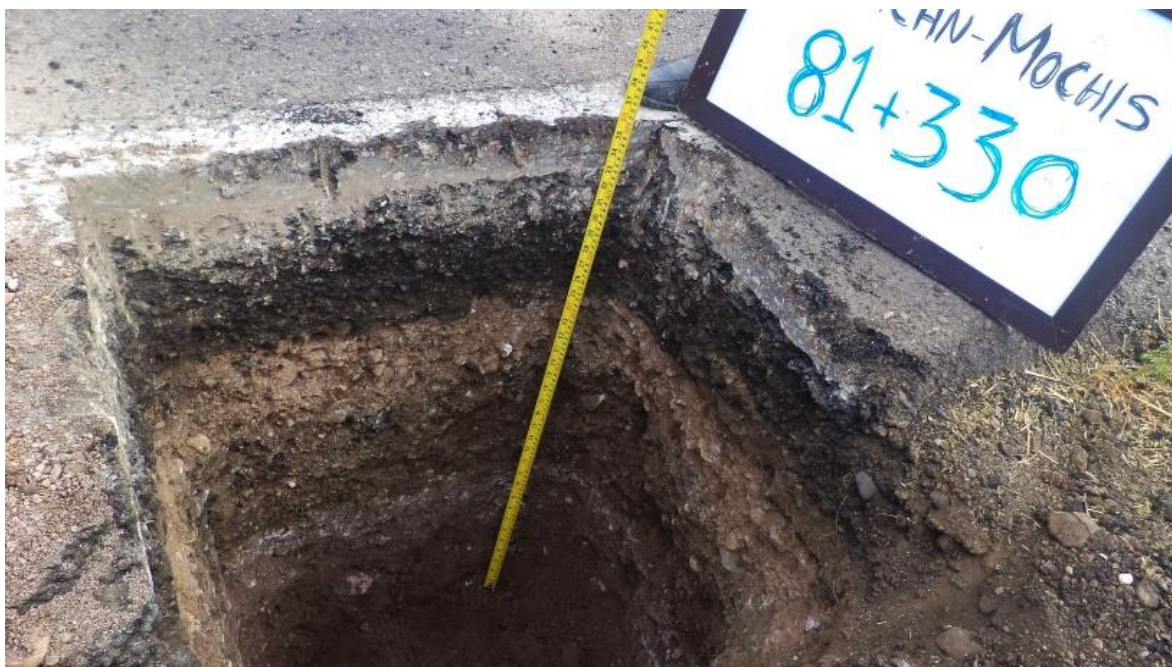
Fig. 5 POZO A CIELO ABIERTO
