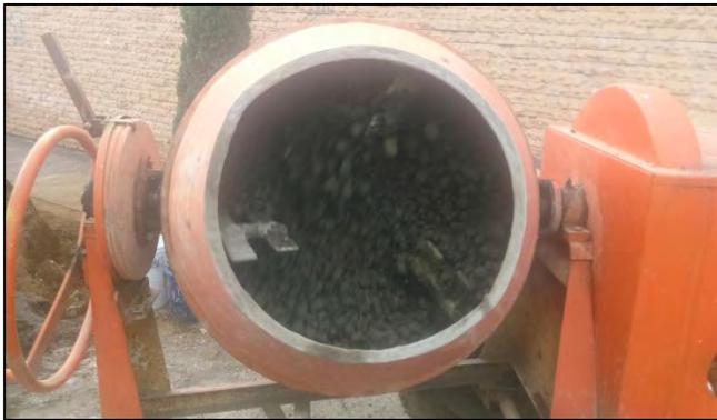
**Fotografía 5.4.2.-** Preparación de la mezcla de CCR en revolvedora.
