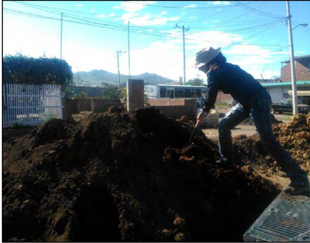
**Fotografía 3.4.5.-** Extrayendo material natural producto de la zanja para el drenaje.
