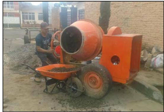
**Fotografía 5.4.3.-** Vaciado de la mezcla de CCR para realizar los especímenes.
