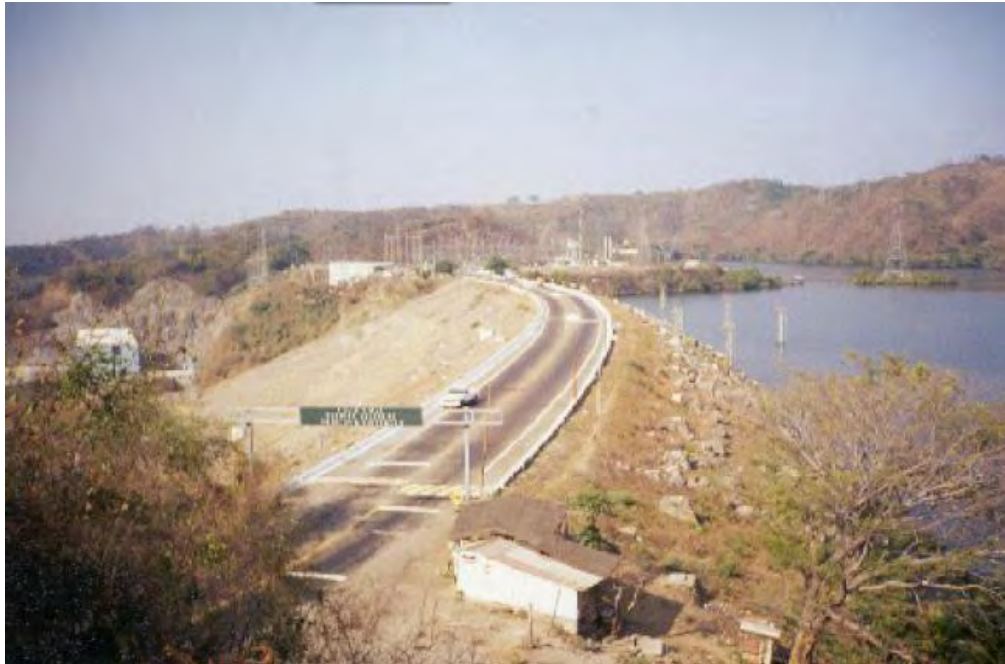
Fotografía 3.2 Cortina de la Presa José Ma. Morelos vista desde margen derecha.
