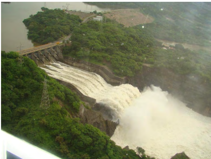
Fotografía 3.4 Vista aérea de Obra de excedencias.
