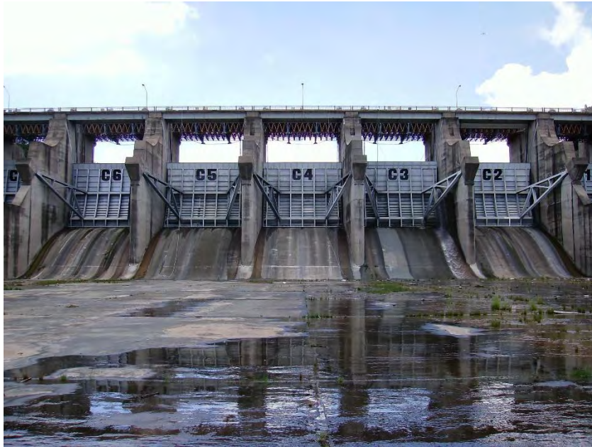
Fotografía 3.3 Obra de excedencias.
