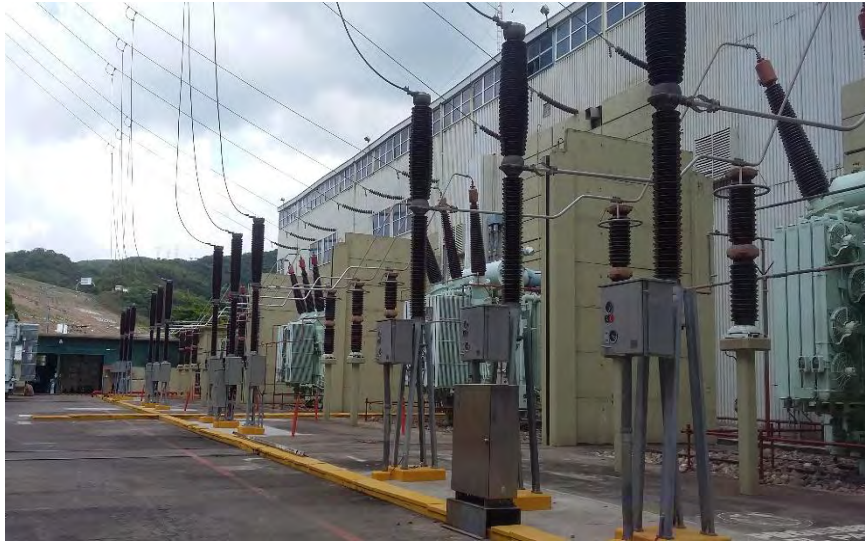
Fotografía 3.6 Transformadores trifásicos.
