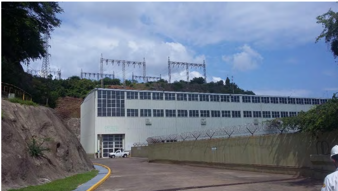
Fotografía 3.5 Casa de máquinas.
