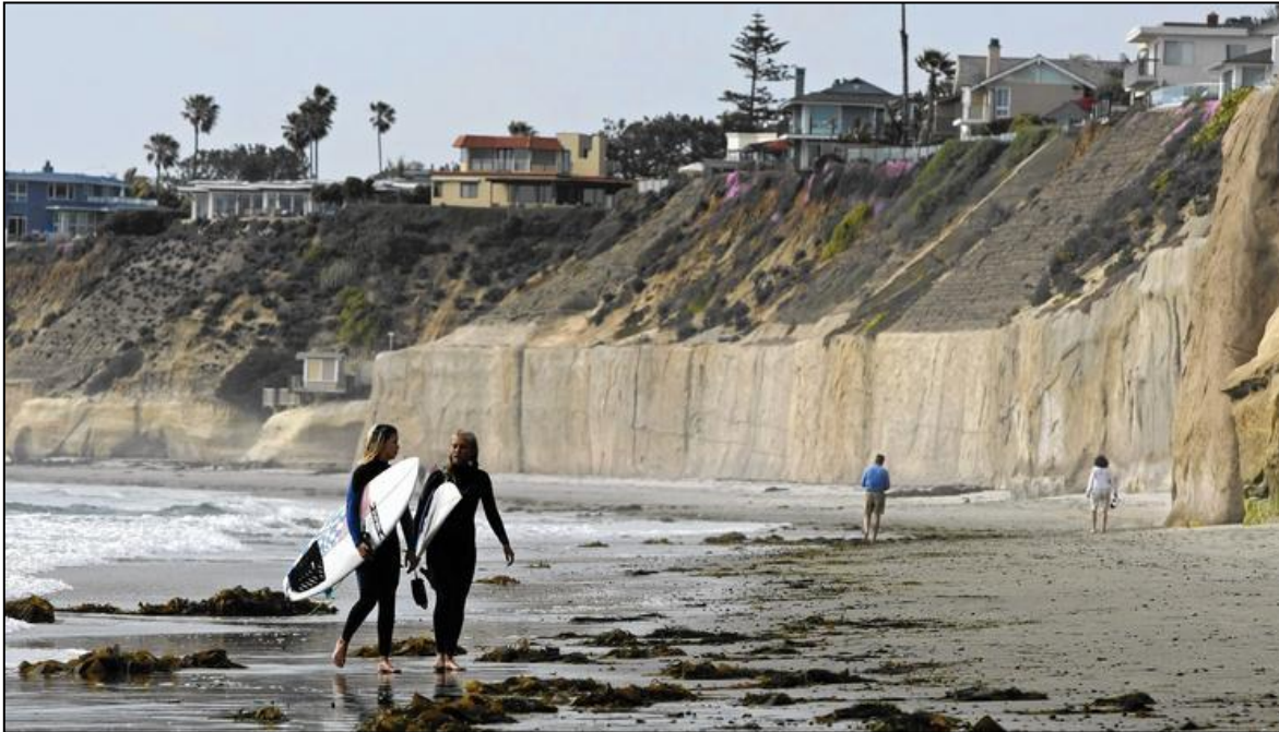
Figura 2-1 Muros de contención alineados a los acantilados en Solana Beach, California, EUA (Don Bartletti/Los Angeles Times, 2016).
