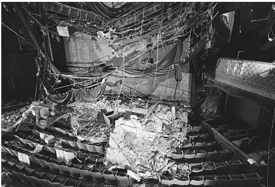
Figura 1.7 Teatro Geary después del sismo de Loma Prieta (SF Gate, 2013).
