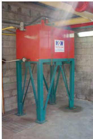
Figura 4.13 Ejemplo de sistemas de mitigación para elementos no estructurales a base de estructura metálica anclados a superficies de concreto (FEMA E74, 2012).
