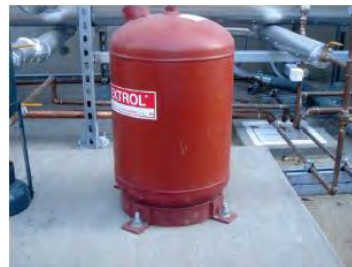
Figura 4.13 Ejemplo de sistemas de mitigación para elementos no estructurales a base de estructura metálica anclados a superficies de concreto (FEMA E74, 2012).
