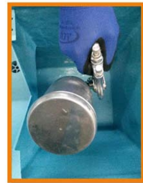
Figura 47: Aplicación de la pintura al depósito de agua.
