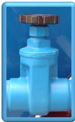
Figura 15.- Válvula de compuerta de dos pulgadas.
