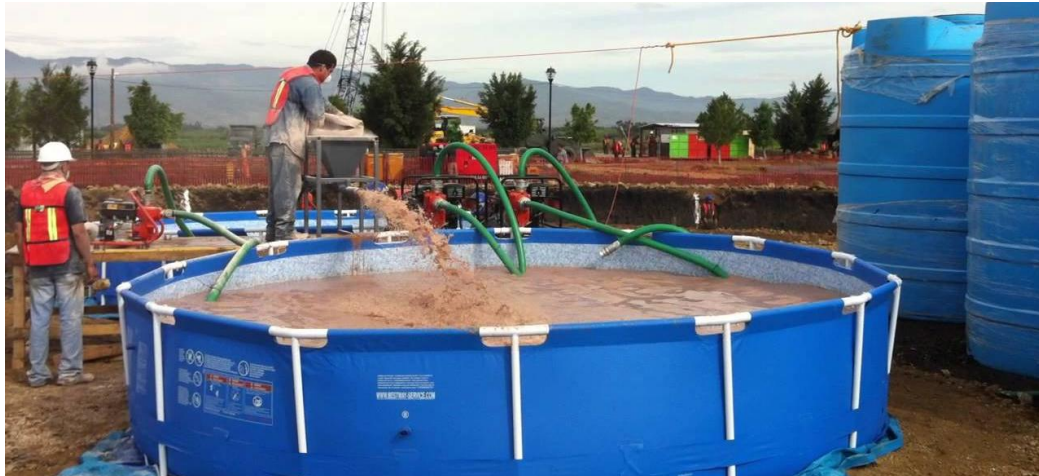
Figura 6. Mezclado y almacenamiento de lodos de perforación
