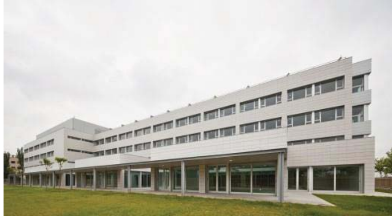
FIGURA 7. Fachada principal de la Residencia asistida. (Pegenaute, Pedro)
