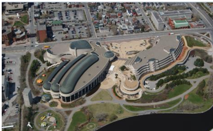
Fotografía aérea de los dos bloques que conforman el Museo canadiense de las civilizaciones. Fuente: Gestión inmobiliaria y servicios de seguridad. Museo canadiense de las civilizaciones.
