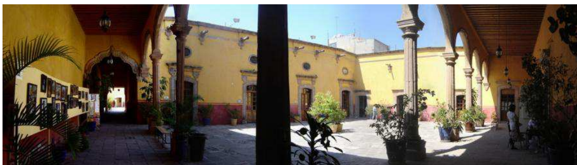
Patio central de Casa del Diezmo.
