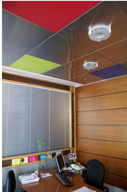
Imagen 134-. Aplicación del sistema de plafón Tile Clip-in
