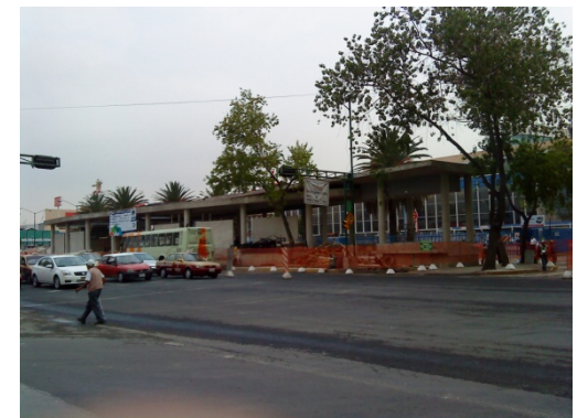
Imagen 53.- Construcción de la parada metrobús
