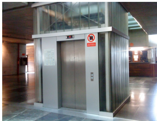
Imagen 65.- Uno de los elevadores ubicado en el pasillo central, únicamente se conecta con el entrepiso
