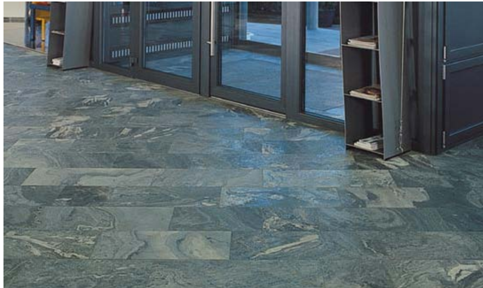
Imagen 123.- Aplicación del efecto mármol con las tintas poliméricas en la zona del vestíbulo principal y áreas abiertas. Combinación del negro con Aqua
