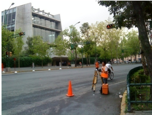
Imagen 54.- Vialidad principal (Eje 1 Norte) frente a la Biblioteca Vasconcelos
