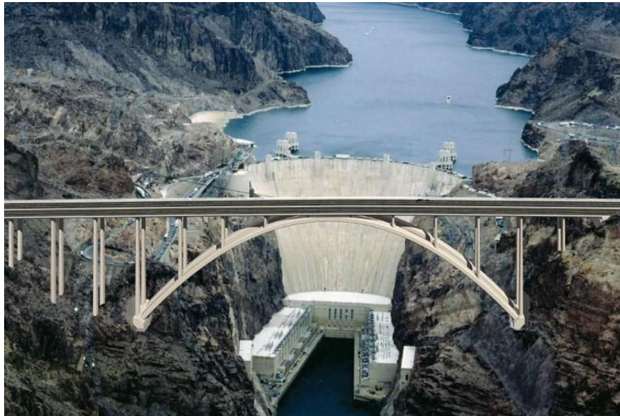
Figura 1.3 Puente de la presa Hoover, U.S.A.
