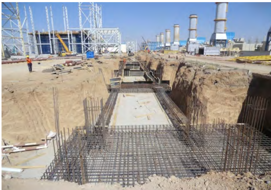
Figura 8.5 Excavación en zanja para las cimentaciones del rack
