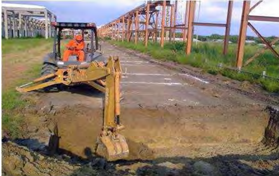
Figura 8.4 Excavación individual para las cimentaciones del rack
