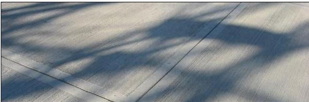
FIG. 2.17. Piso de concreto con acabado escobillado y cortes constructivos.
