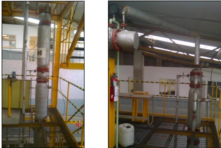
FIG. 4.36. Fotografía del Domo de la Columna de Destilación.
