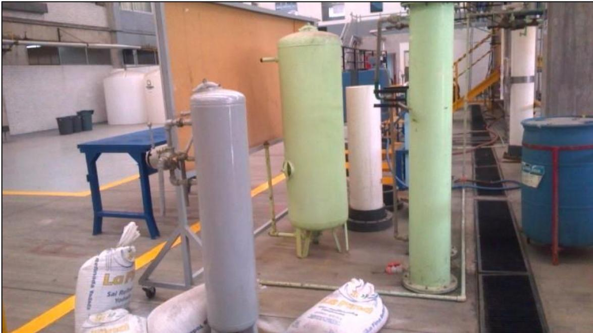
FIG. 4.16. Fotografía de Tanques de Intercambio Iónico.
