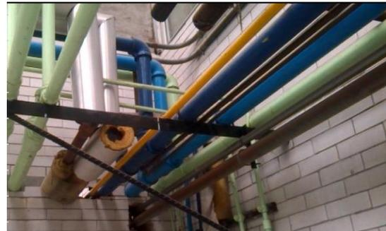
FIG. 3.3. Código de identificación de colores de Tuberías en Planta Piloto FES Zaragoza.
