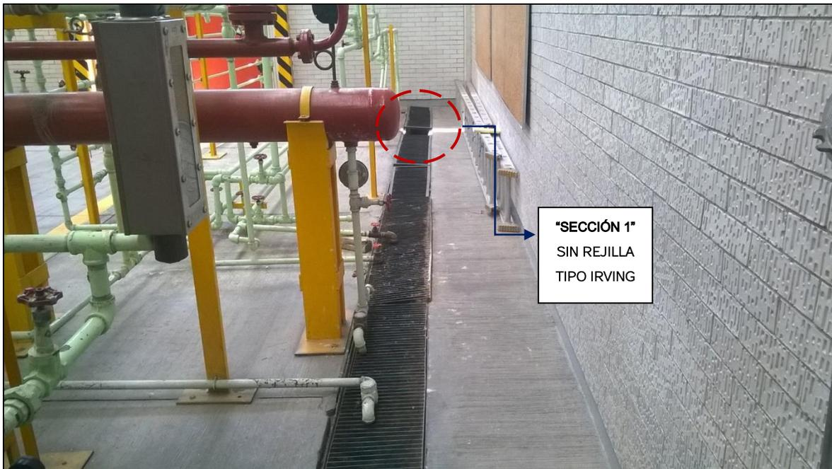
FIG. 5.13. Fotografía de la "Sección 1" sin rejilla tipo Irving
