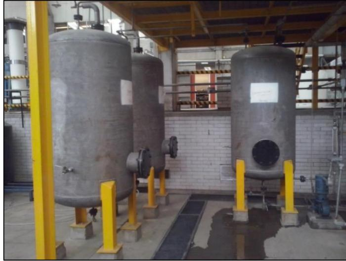
FIG. 4.34. Fotografía de Tanques de Alimentación, Destilado y Fondos.
