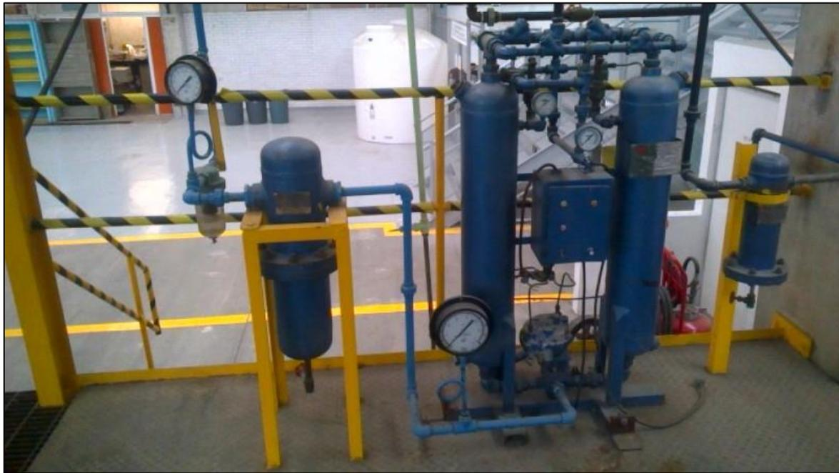
FIG. 4.41. Fotografía de Equipo secador de aire.
