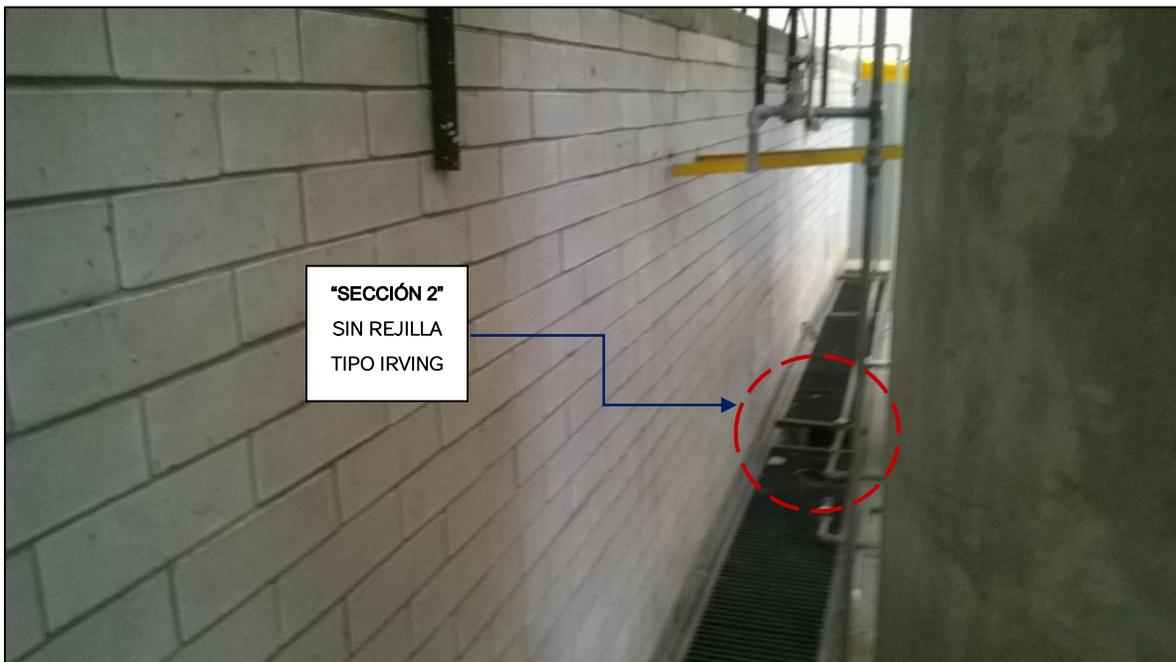
FIG. 5.14. Fotografía de la "Sección 2" sin rejilla tipo Irving
