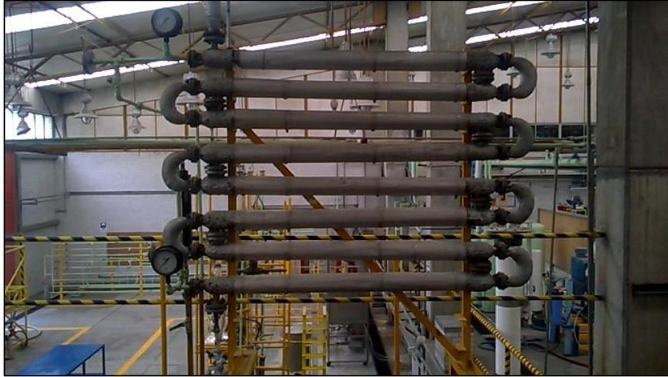
FIG. 4.38. Fotografía del Condensador localizado en el segundo nivel.
