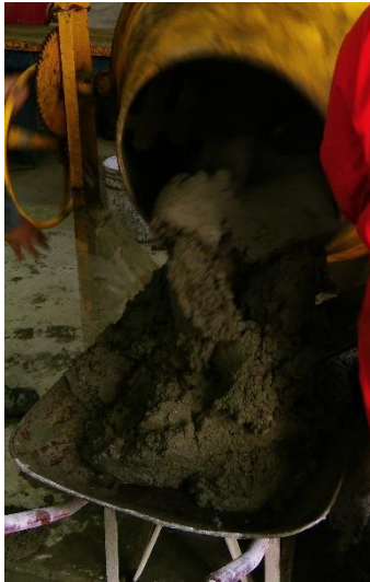
Figura 2.2 Mezcla de concreto lanzado “M8”, con 10% de ceniza volante como sustituto de cemento e inclusión de aire de 4.9%.
