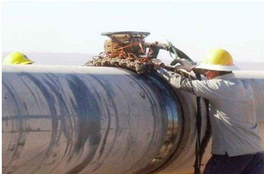
Fig. 6.5 Biselado de ducto. [Fotografía]. Recuperado de: http://www.warriors.com.pe/foro/index.php?topic=1728.90 .
