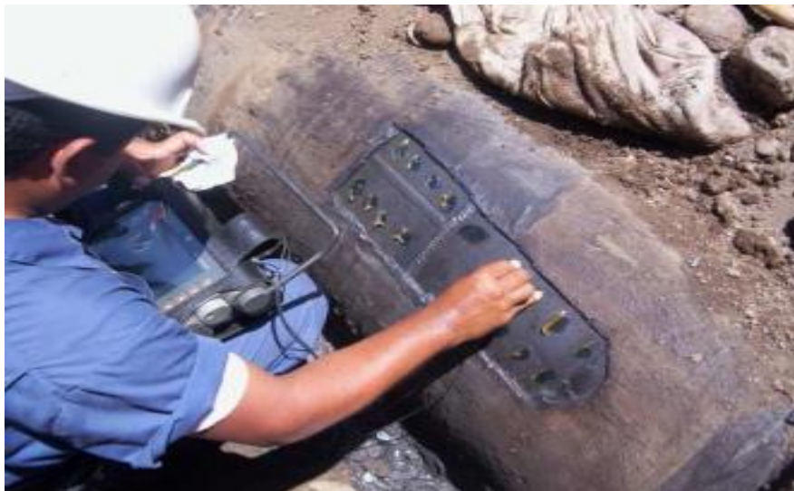
Fig. 6.3 DUCOMSA. (2011). Inspección. [Fotografía]. Recuperado de: http://www.ducomsa.com/servicios/inspeccion/
