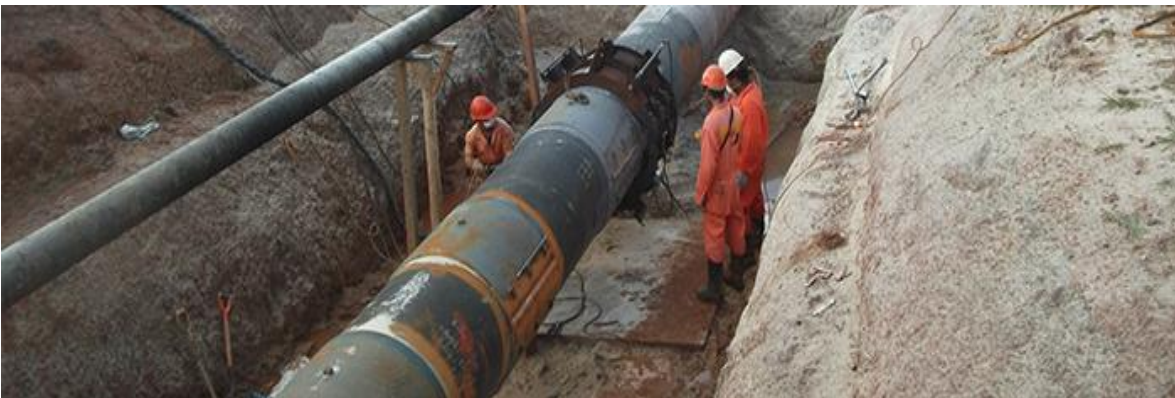
Fig. 6.9 Reparación con Camisas Compuesta. [Fotografía]. Recuperado de: http://cobsa.mx/15177/construccion-y-rehabilitacion-de-lineas-de-conduccion-de-hidrocarburos
