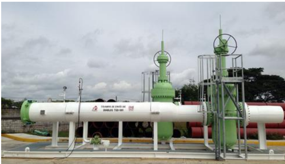
Fig. 5.16 lanzador de “pig” [imagen] PEMEX-Cirratech Industrial. Recuperado de: http://www.cirratech.com.mx/english/ .
