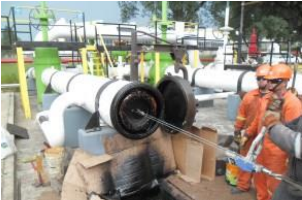
La Figura 5.7 Corrida de “Pig” [FOTOGRAFIA]. PEMEX, (2007).
