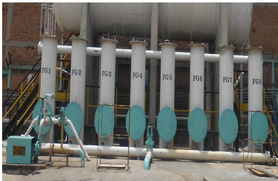
Figura 2.5 Sistema de filtración en paralelo
