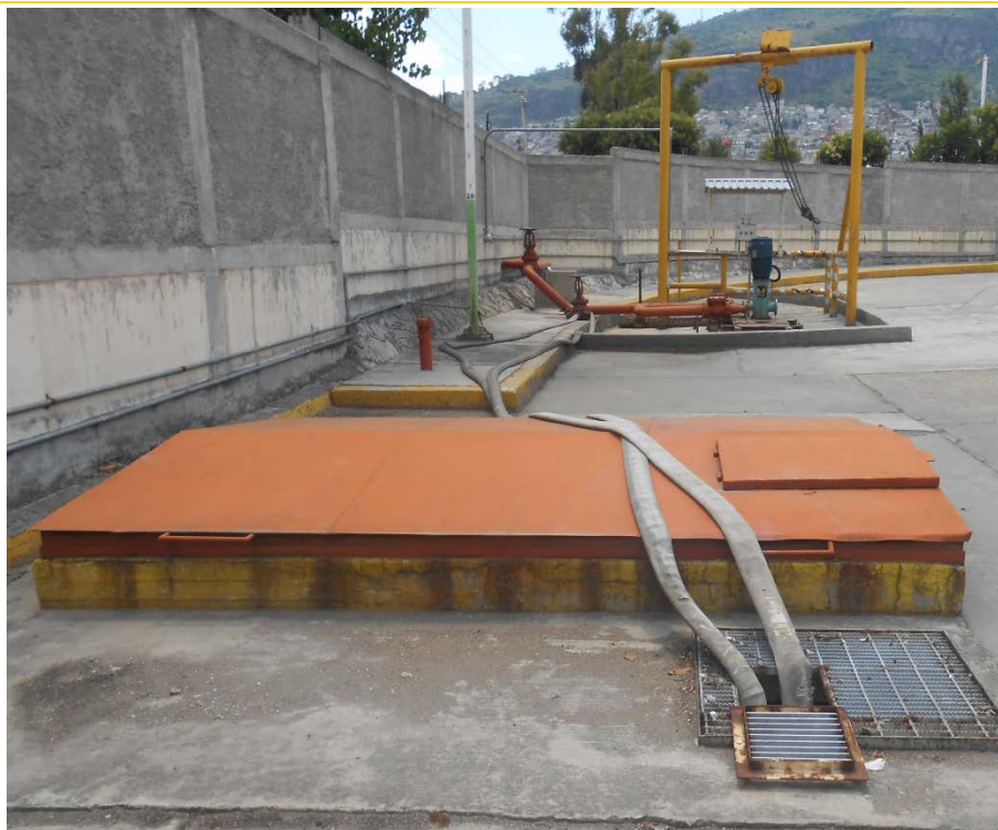
Figura 2.1 Cárcamo de recuperación y final
