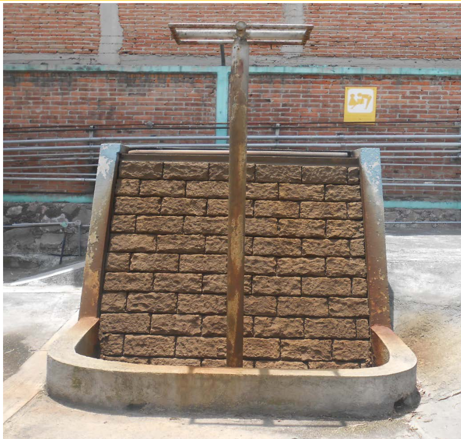
Figura 2.7 Fuente de aereación
