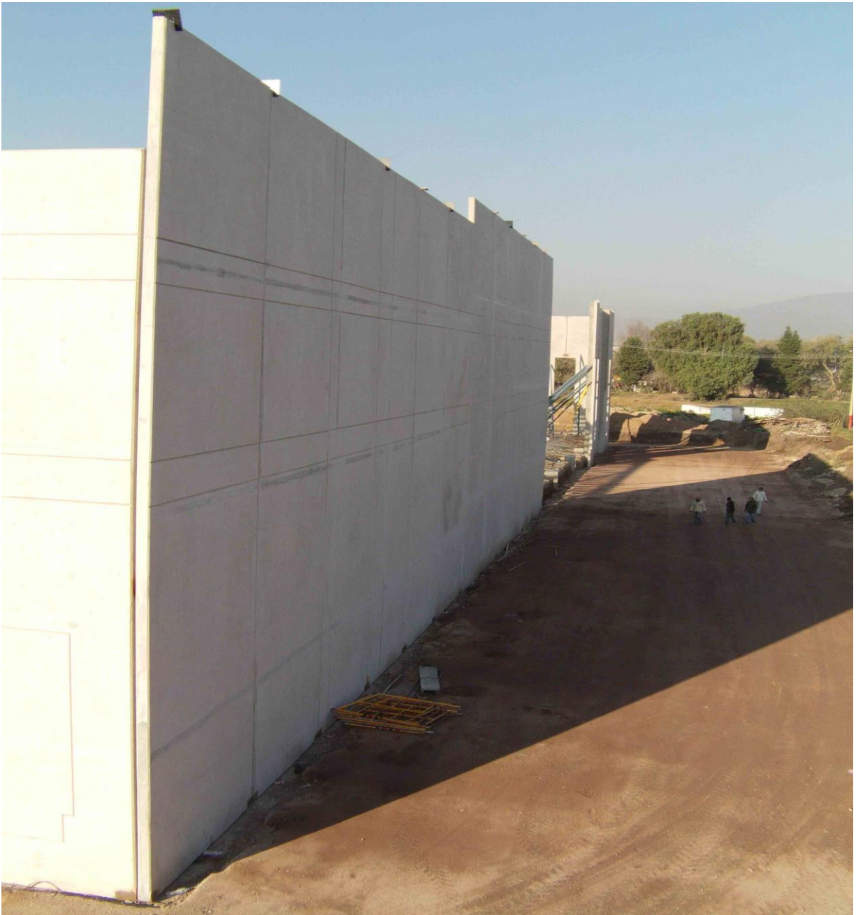
Fotografía A. 3. Unión exterior de esquina de muros tilt-up, se puede observar la modulación vertical y horizontal entre paneles de muros
