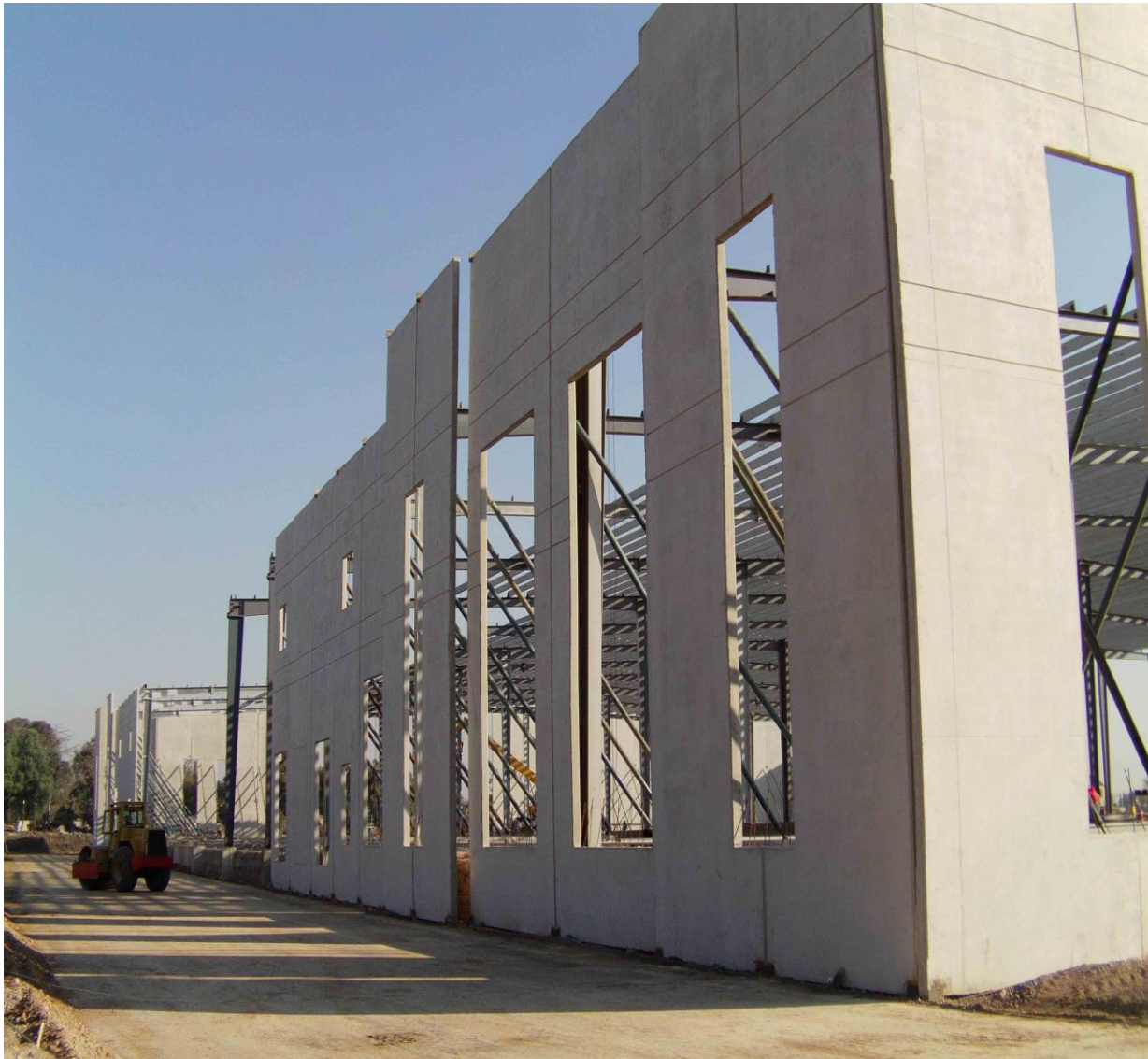
Fotografía A. 2. Apuntalamiento temporal interior sobre muros tilt-up con ventanas
