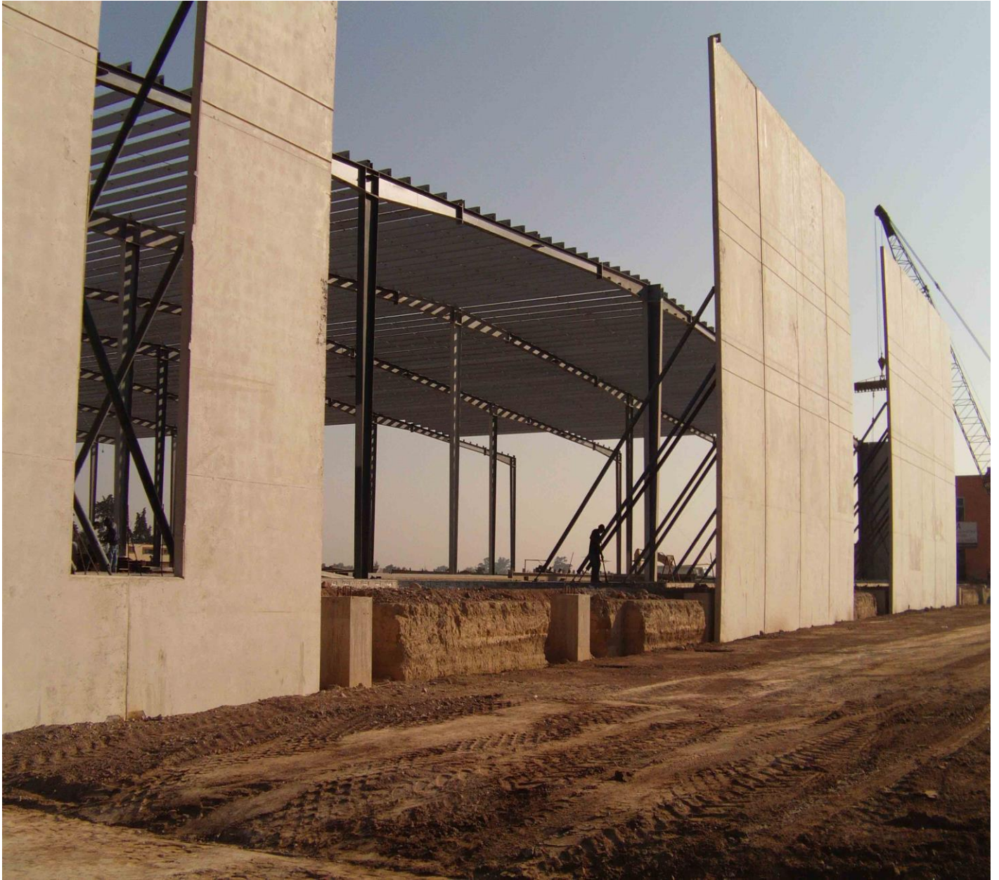
Fotografía A. 4. Proceso de montaje muros tilt-up contra estructura principal
