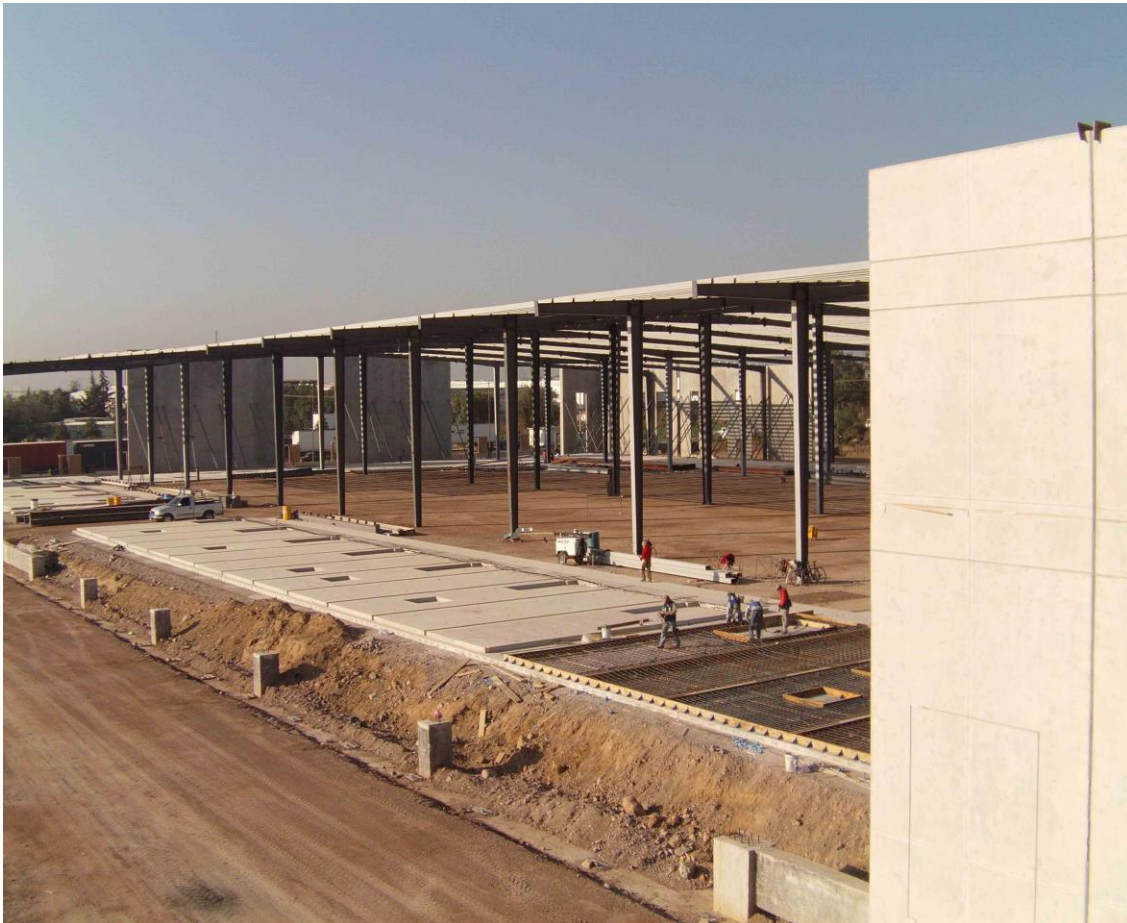
Fotografía A. 1. Muros colados y armados sobre piso
