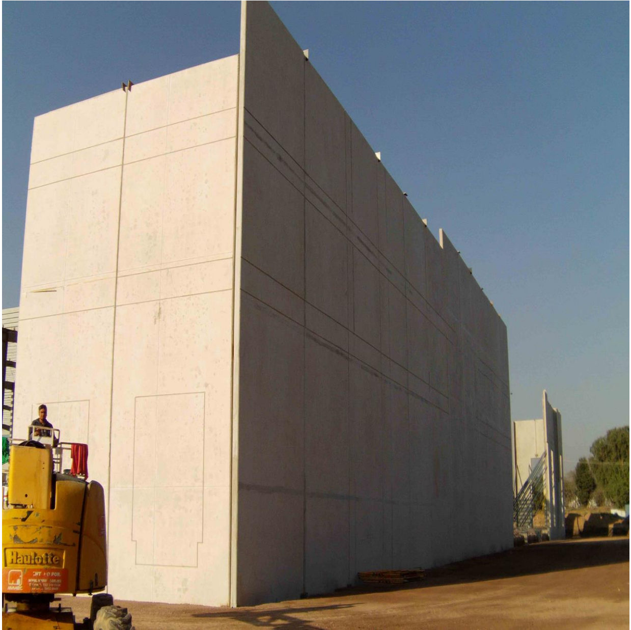
Fotografía A. 5. Fachada norte
