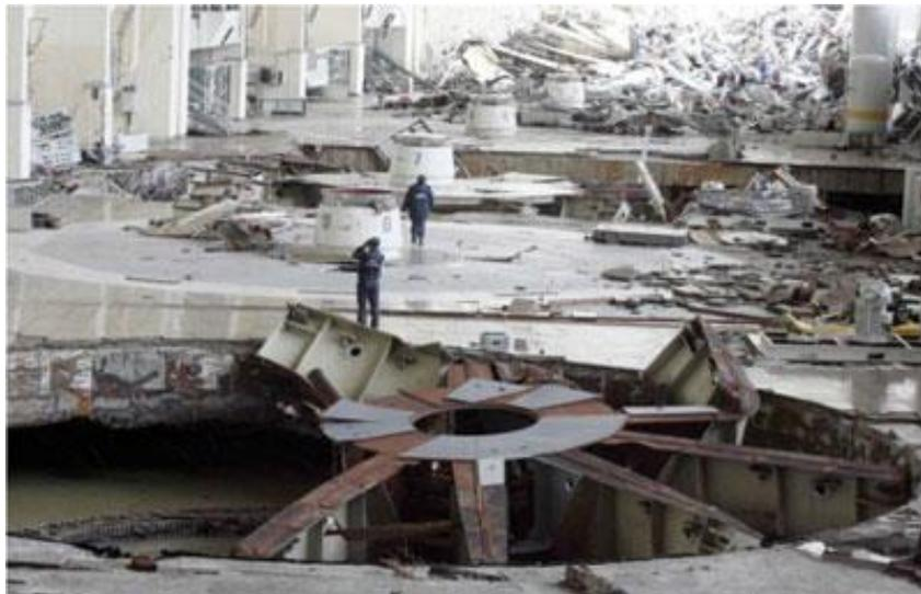
Figura 2. Fotografía de la falla de grupos turbogeneradores en la central Sayano-Shushenskaya, Siberia (Ray, 2010)
