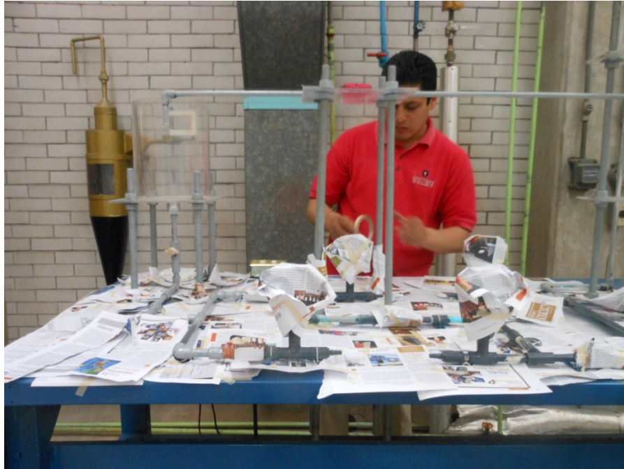
Figura 4.8 Se preparó el trabajo de pintura
