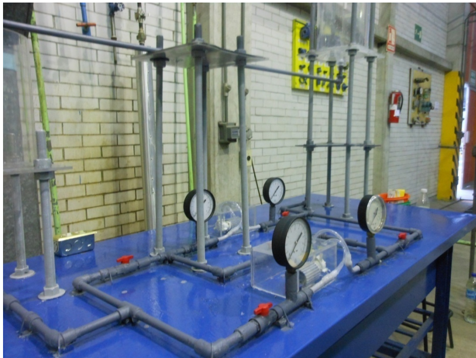
Figura 4.15 Foto del sistema con cuatro manómetros
